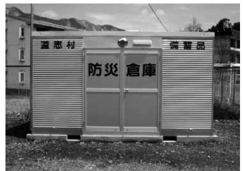
※ 中学校に設置された防災備蓄倉庫
