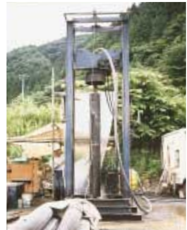
温泉掘削状況
