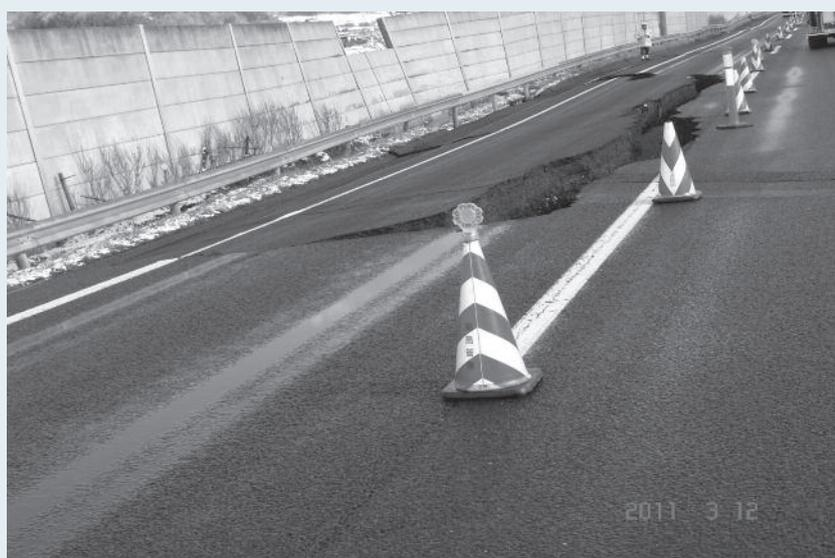
東北自動車道の仙台IC付近の写真で地震の影響で至るところに亀裂が入り緊急の復旧工事をしていました。
