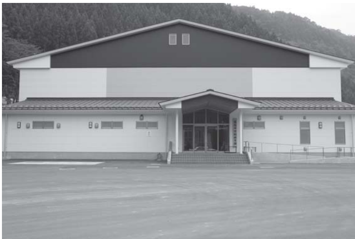
道志中学校体育館
