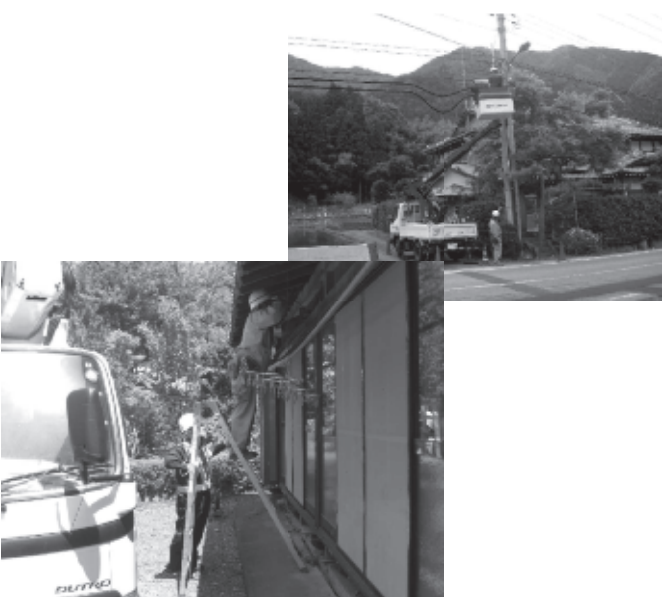
光ケーブルの引込状況
