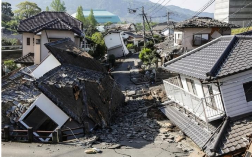
写真：熊本地震による家屋の倒壊
